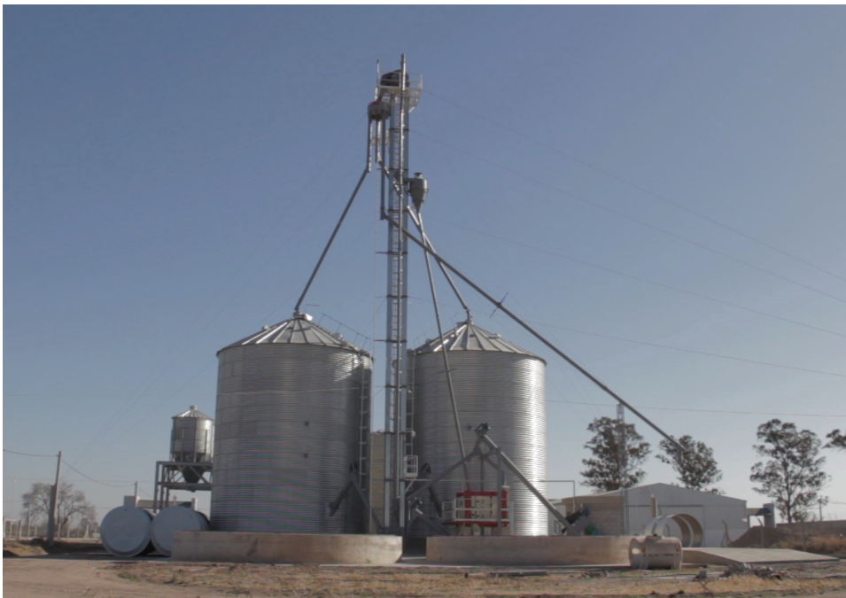
Vista externa de la planta con silos de almacenaje.
