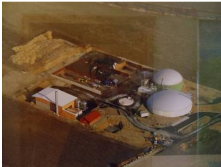
Vista aérea de la planta del pueblo energético Jühnde. Comienza a funcionar en el año 2006.
