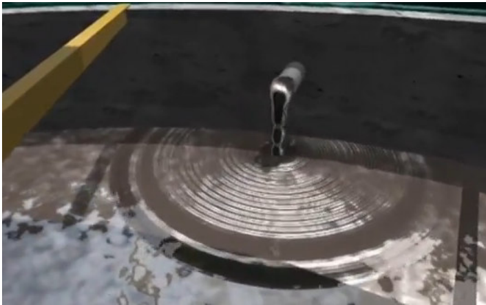
Tanque de almacenamiento de los residuos producidos por el sistema que podrán ser empleados como fertilizantes para uso propio o de terceros.
